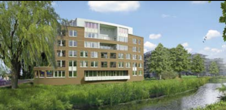
Ravel, Zutphen (Roggeveen & Piso)
